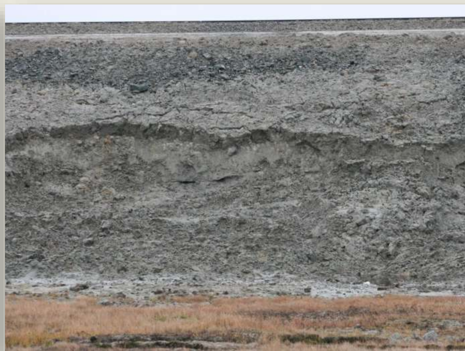
Размыв и сплывы грунта с неукрепленных откосов насыпи
