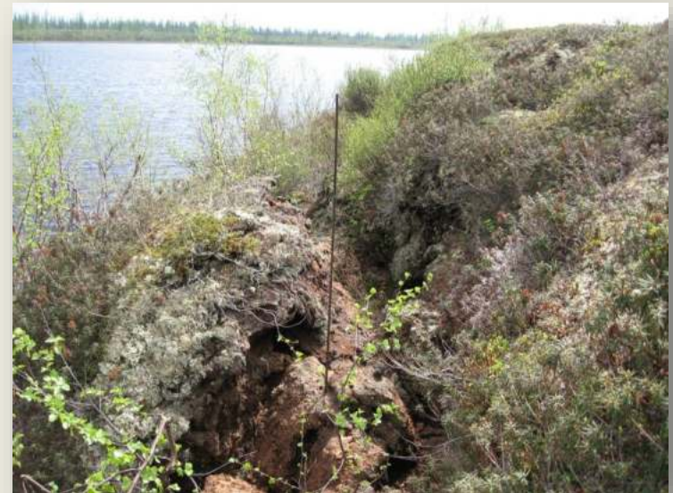
Трещины и блоки отседания в торфянике
