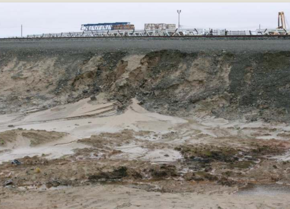
Размыв и сплывы грунта с неукрепленных откосов насыпи
