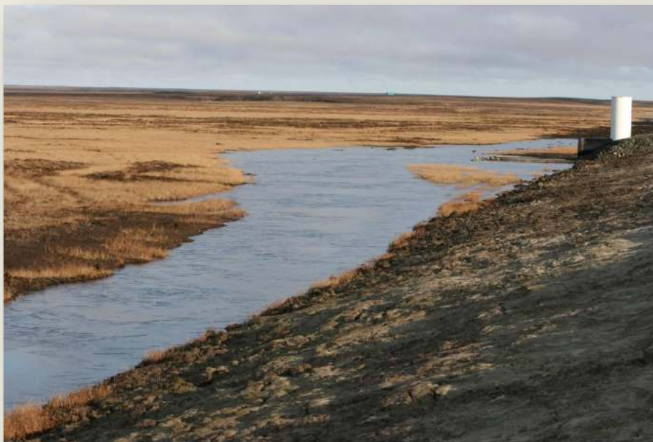
Обводнение и заболачивание территории, примыкающей к насыпи
