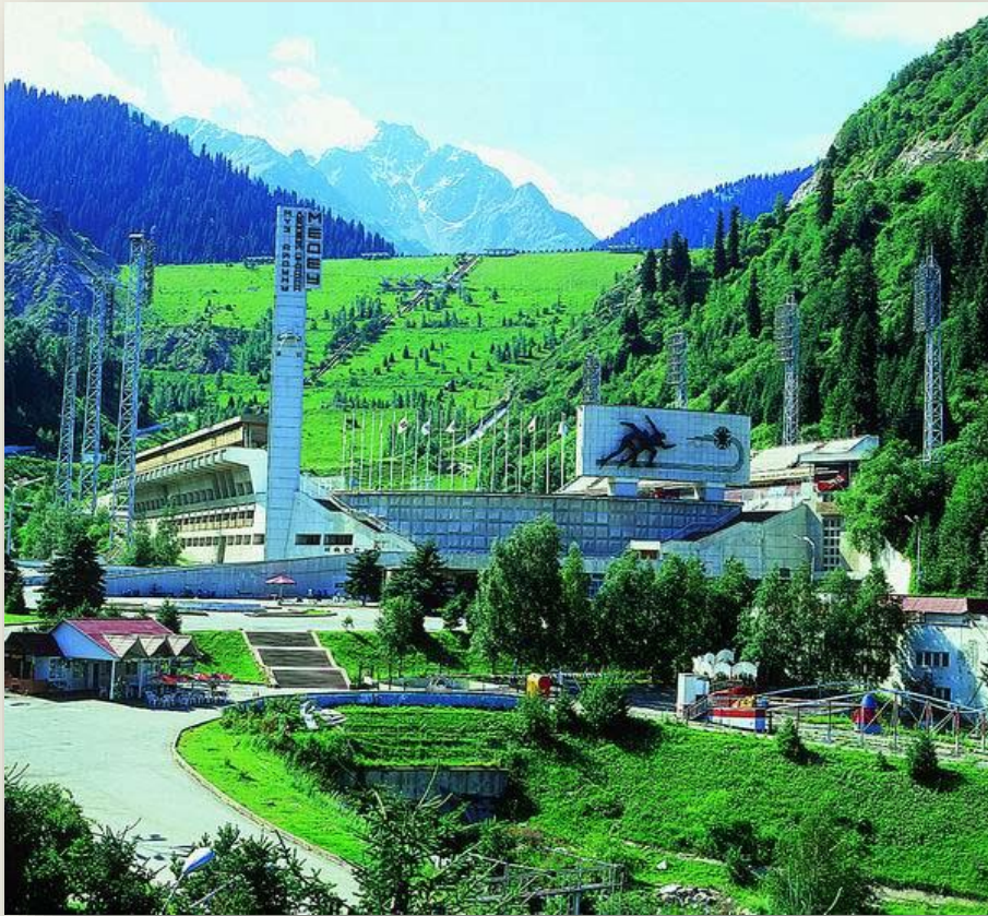
Ледовый стадион и плотина Медео. Высота плотины 150 м (первоначально 100 м)
