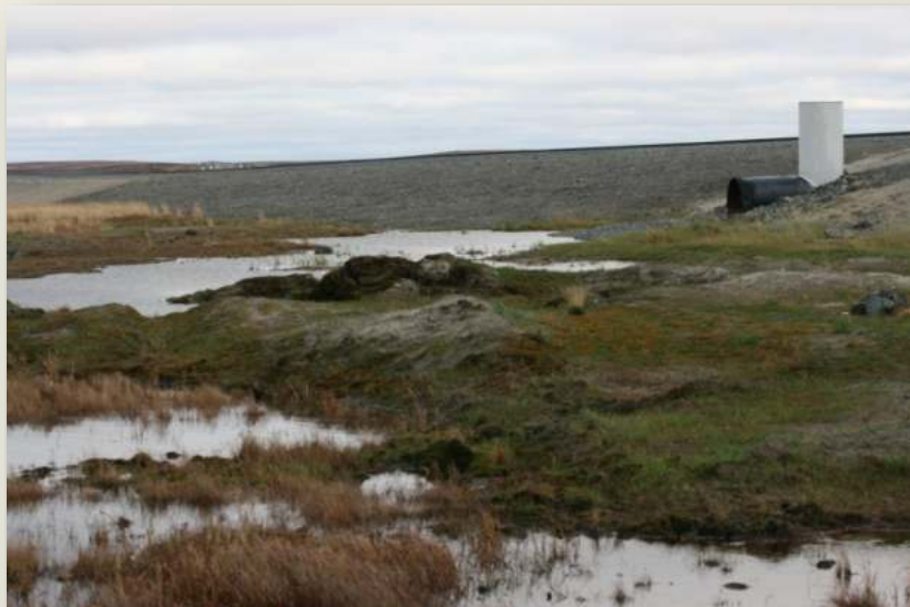
Обводнение и заболачивание территории, примыкающей к насыпи
