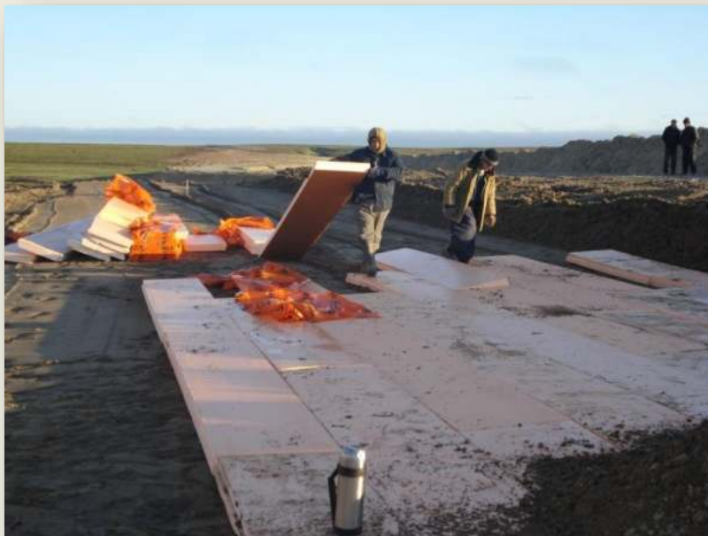
Укладка теплоизоляционных плит из пеноплекса в тело насыпи
