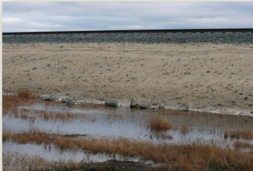
Обводнение и заболачивание территории, примыкающей к насыпи
