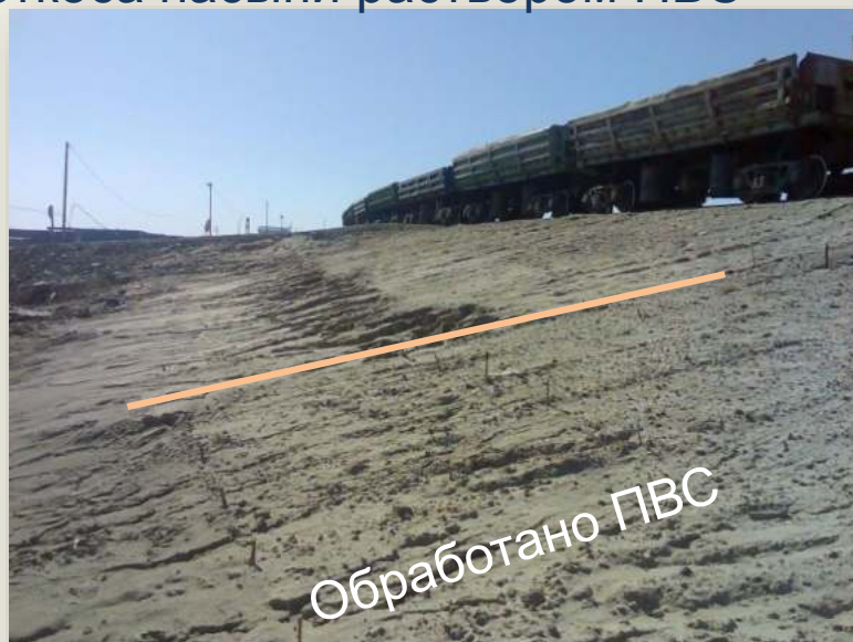
Противоэрозионная обработка откоса насыпи раствором ПВС
