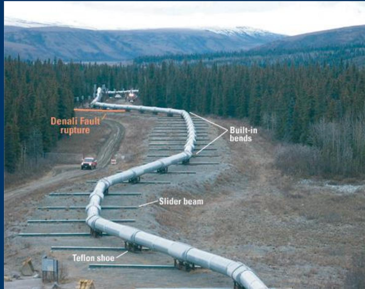
Переход Трансаляскинского нефтепровода через разлом Денали. В ноябре 2002 г. при землетрясении с  $M_w = 7.9$ , смещение по разрыву составило 5.6 м при расчетной подвижке 6 м. Трубопровод выдержал.
