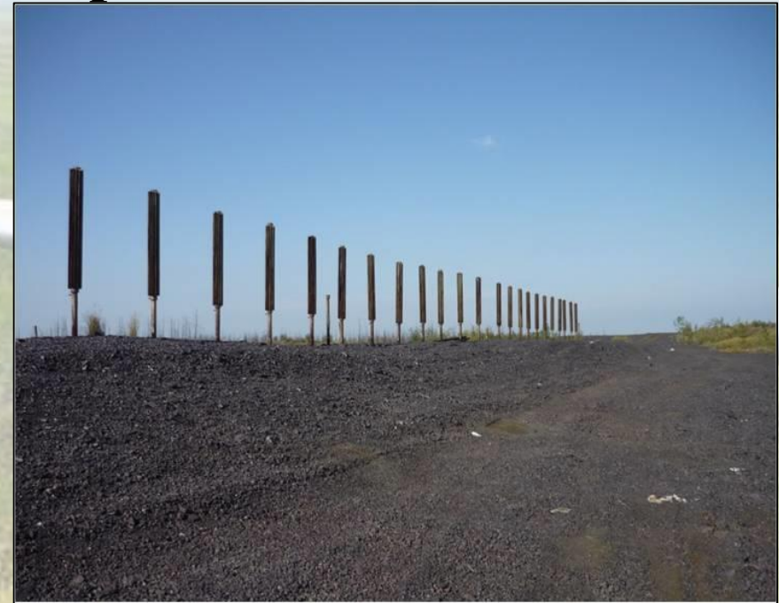
Парожидкостные термоустановки, г. Норильск
