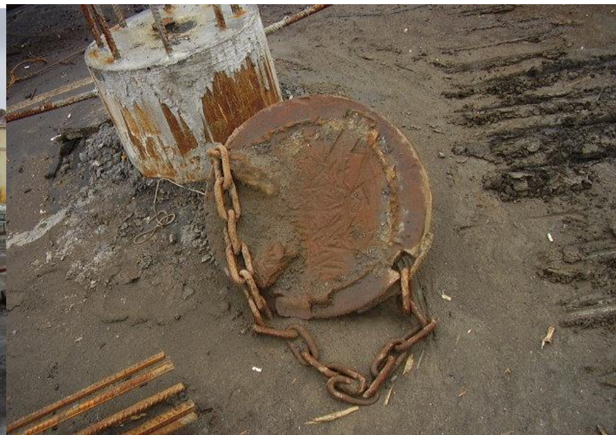
Для опускания обсадной трубы на нужную глубину используют «обсадник»
